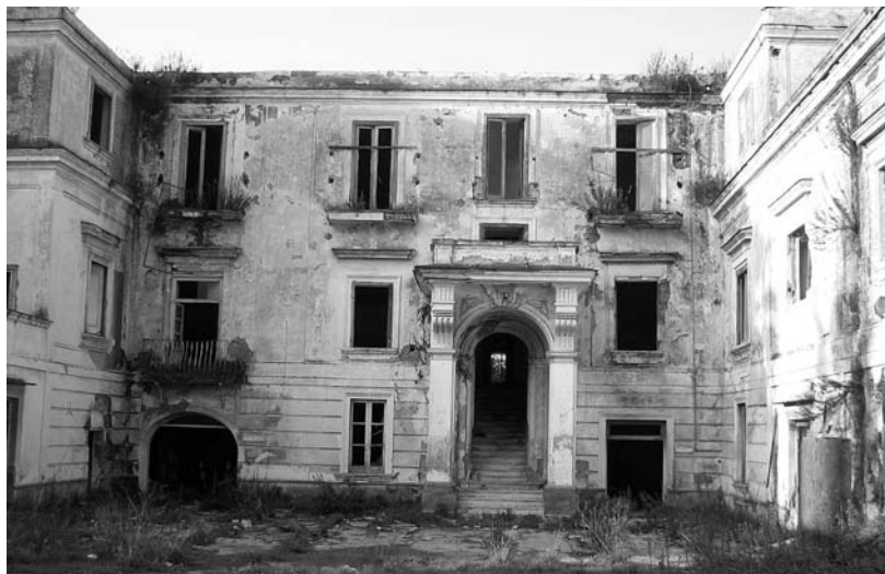
FOTO 24 - Lo stato attuale della struttura di Ponticelli
